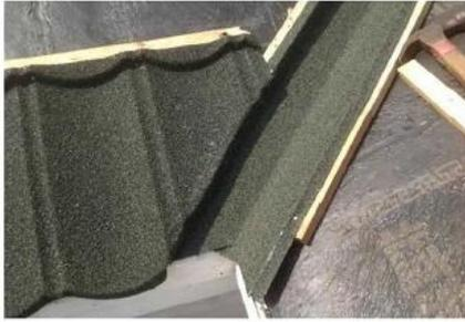
示意图4: 天沟安装示意图
