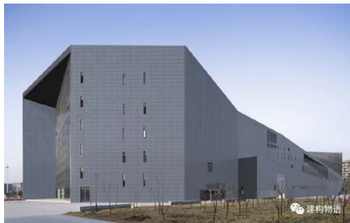
南京大学仙林校区——深灰色的水平向 ECP 板 ( 图片提供: 北新绿色住宅有限公司 )
