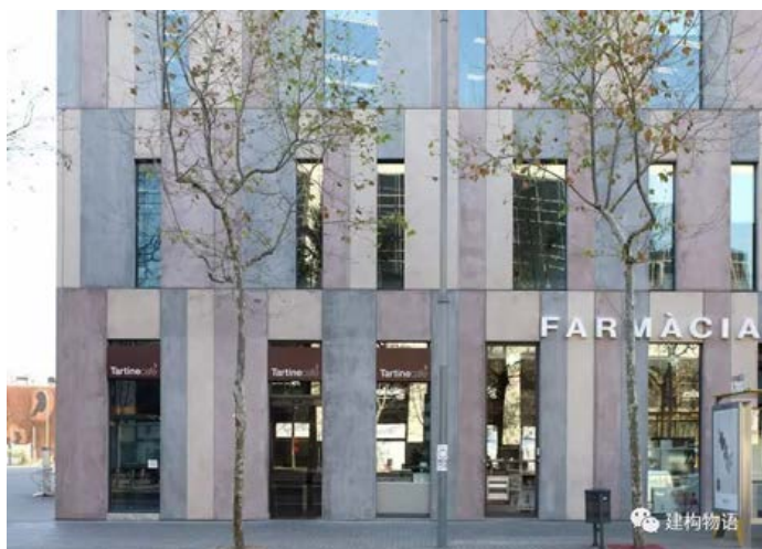
西班牙巴塞罗那某公寓楼的 预制彩色混凝土墙板 ——与中空水泥板效果有类似之处。
