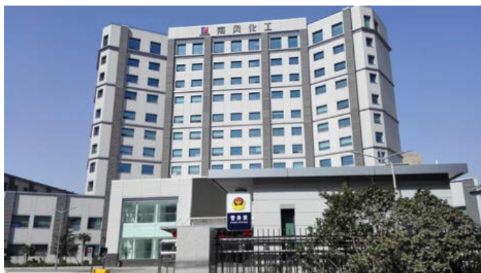
山西南风化工项目（节能改造：金邦板装饰系统）
