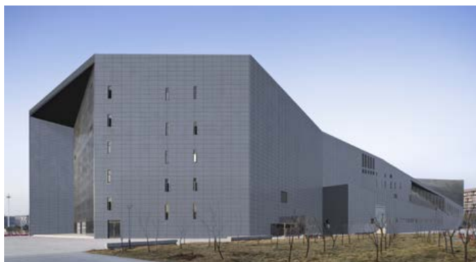
南京大学仙林校区（节能改造：金邦板外墙外保温装饰系统）
