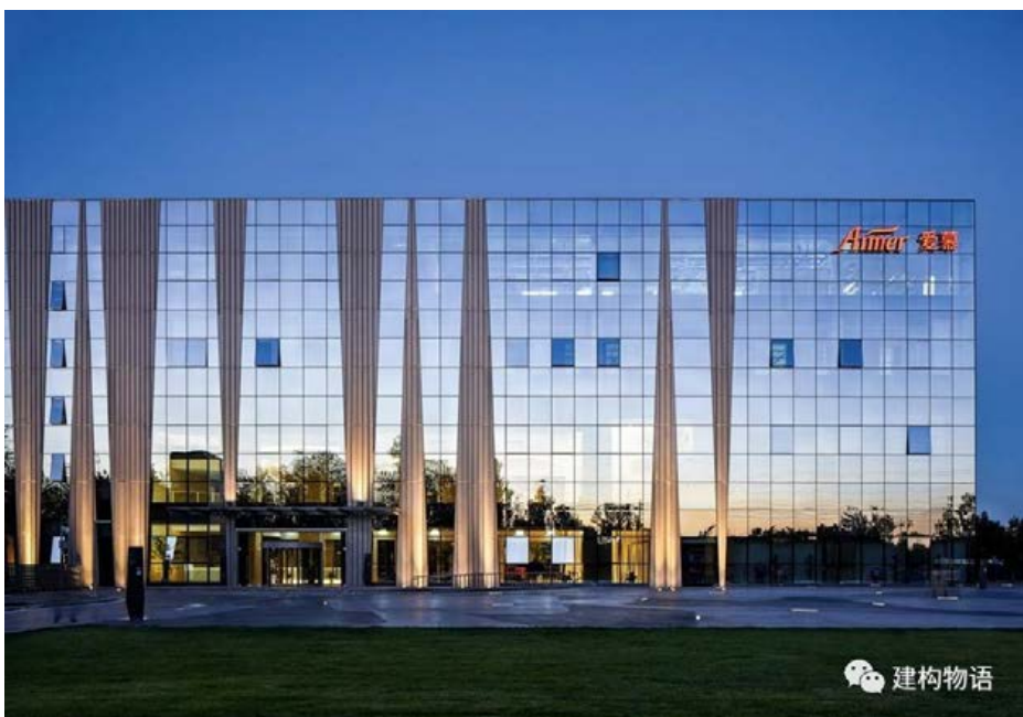
厂区西侧外观
