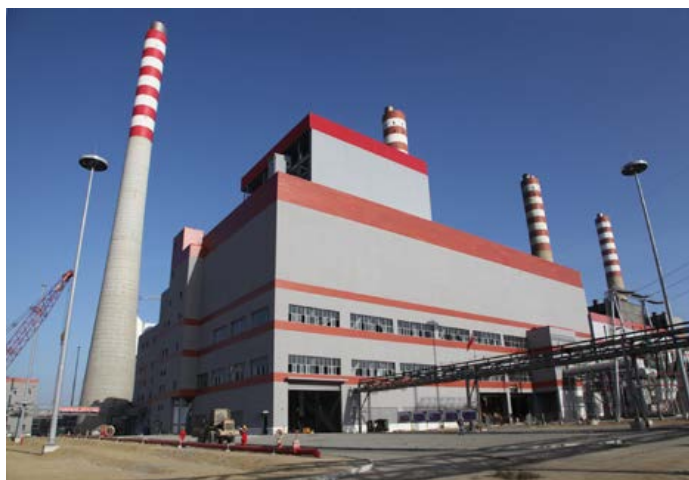
委内瑞拉中央电厂（钢结构：金邦板装配式复合外墙系统）
