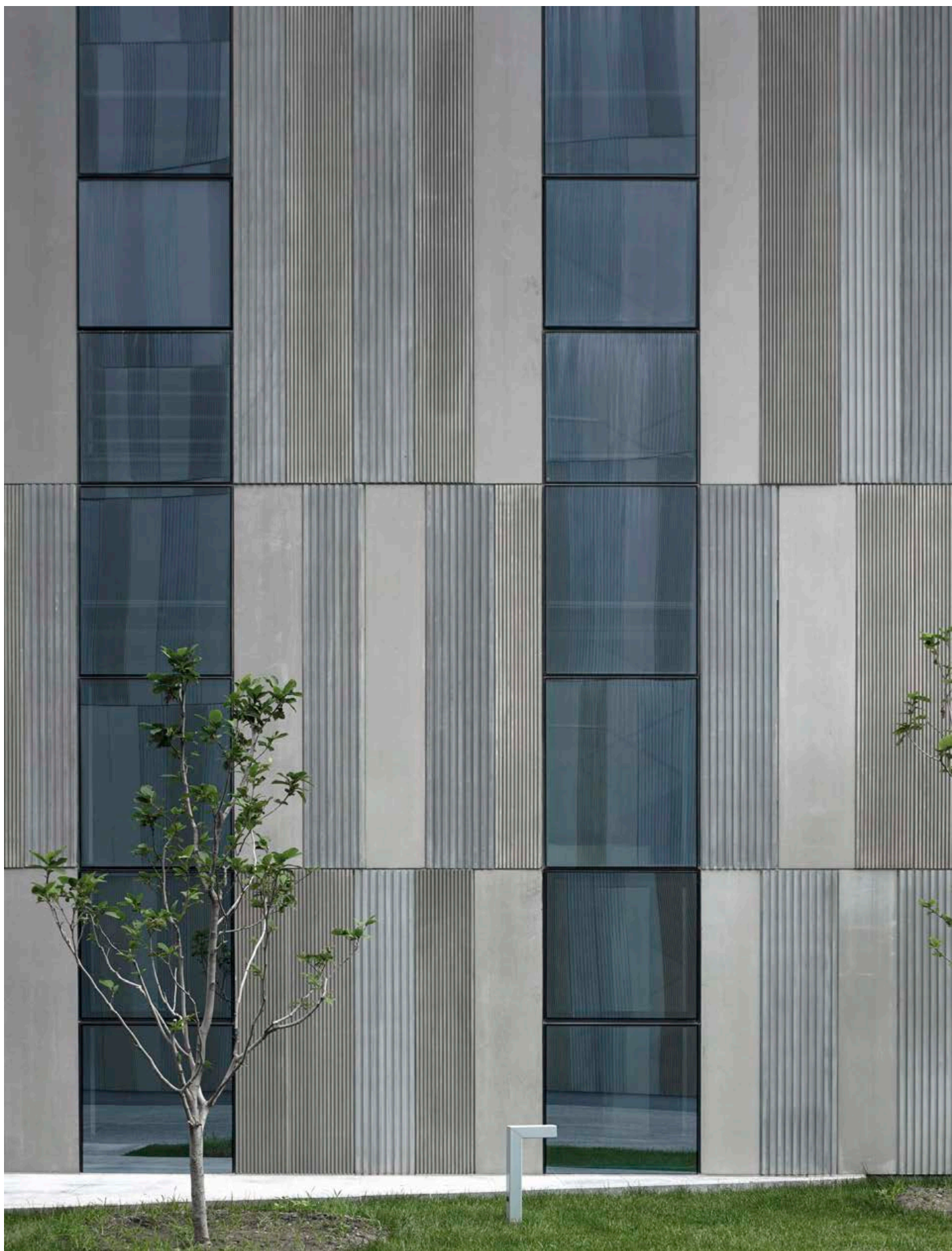
采用不同色彩、质感、肌理的挤出成型中空水泥板组合而成的幕墙外立面
