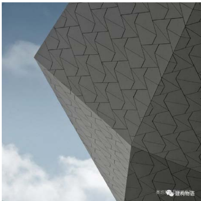
奥地利蒂罗尔音乐厅 建筑师：DMAA 事务所 （图片提供：广州埃特尼特建筑系统有限公司） 典型的 单层纤维水泥平板 形成的效果，建筑师可以通过标准板材的裁切控制立面板块的形状。
