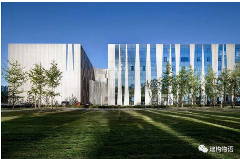
厂区西侧外观
