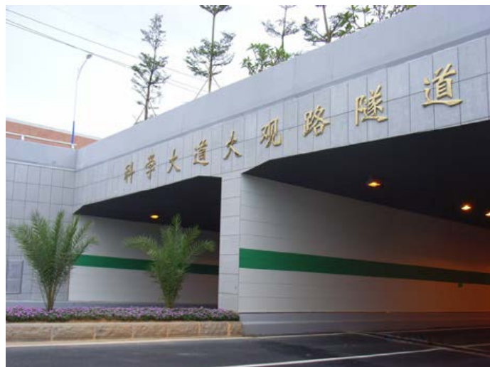
广州大观路地下隧道（地下围护：金邦板装饰系统）
