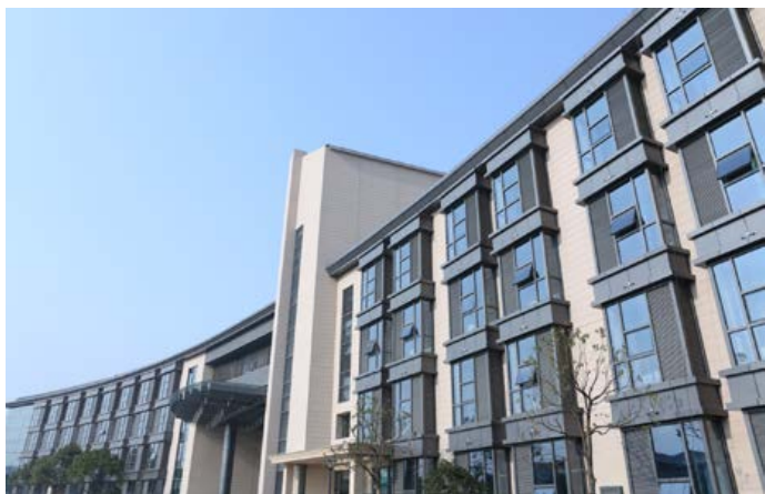
苏州工业园区项目（金邦板外墙外保温装饰系统）
